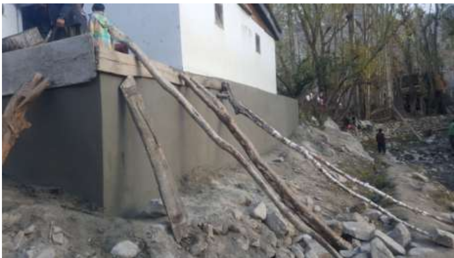
Opravená zeď pod nemocnicí
